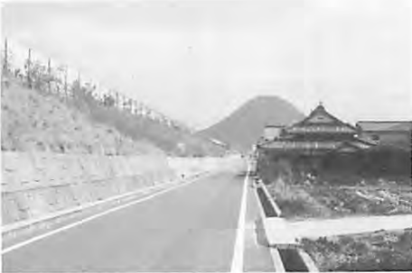
● 高松自動車道と側道
